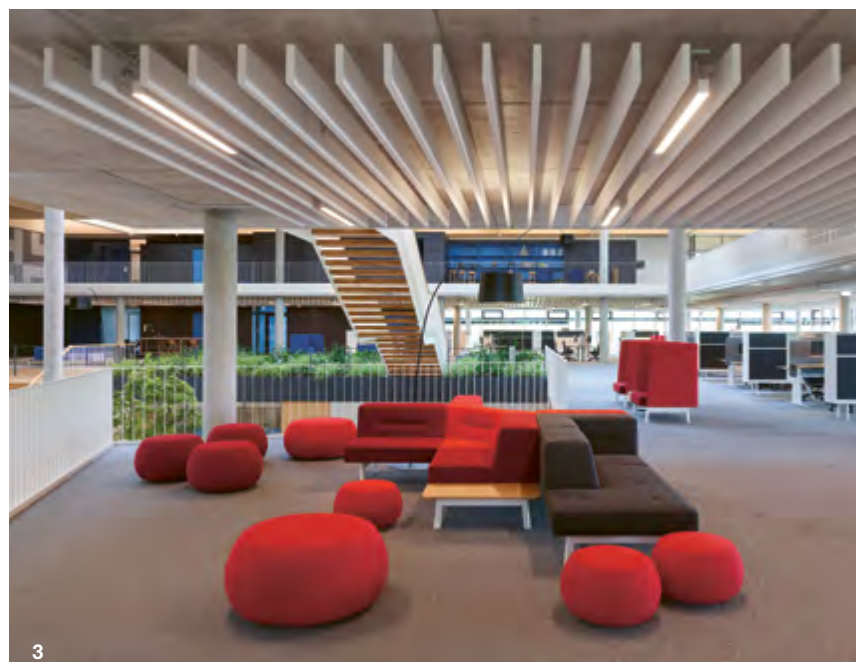
1 – 3 Das Dach des Logistikzentrums und der Verwaltung der Promega Group in Mannheim, eine Holzträgerrostkonstruktion, wird von Stahlbetonstützen getragen, die im Schleuderbetonverfahren hergestellt wurden.
