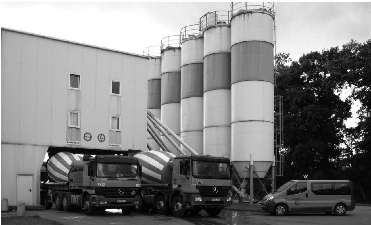
Bild 1: Lieferung von Transportbeton mit dem Fahrmischer
